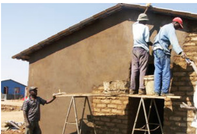
Bau eines Lehmhauses
